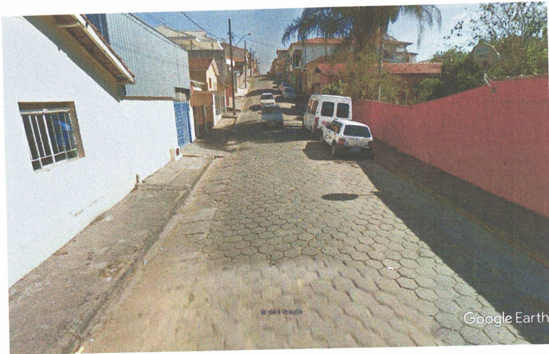
RUA CÂNDIDO LAMY
